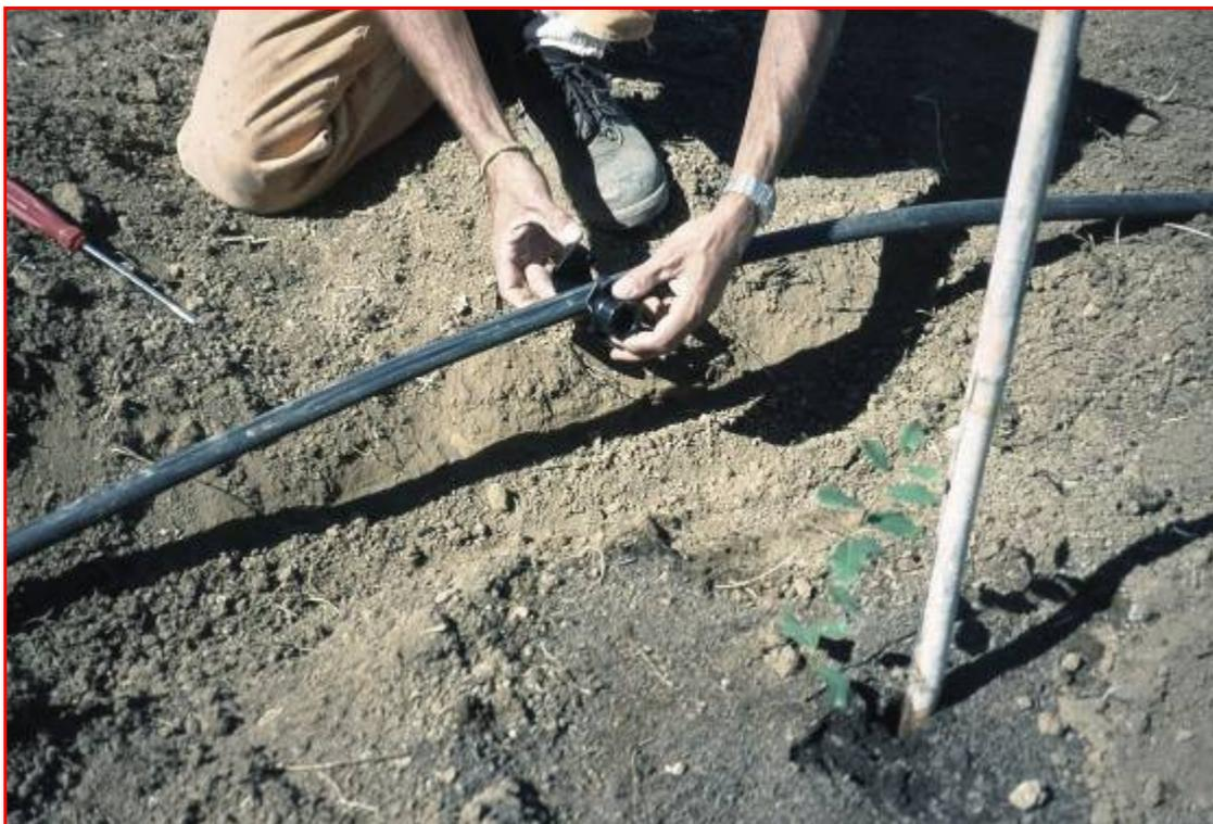
*In prossimità della pianta da irrigare è inserita sul tubo una presa a staffa*
