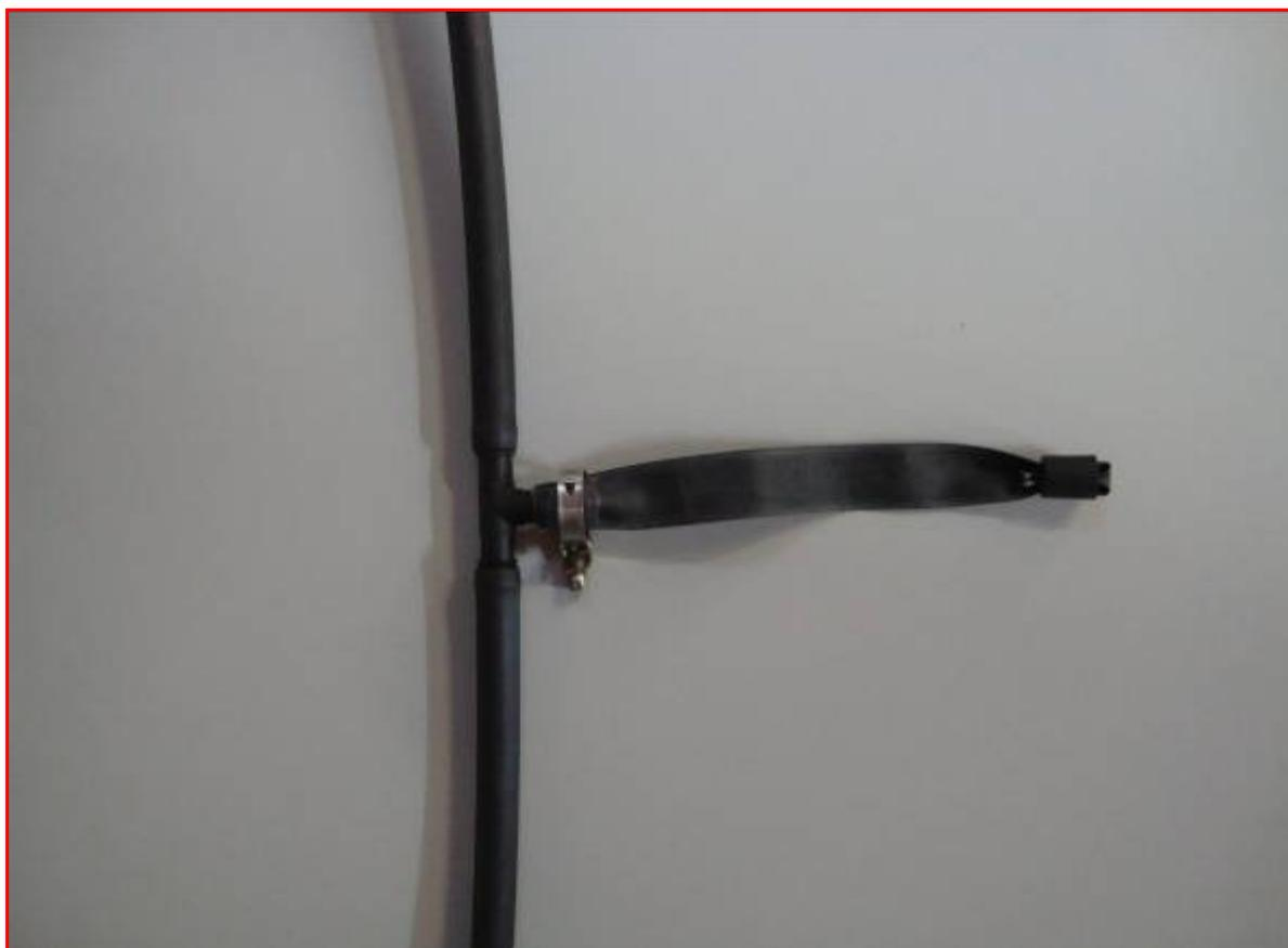
*Realizzazione di linee terminali di adattamento con il tubo geotessile essudante. Con questo sistema è possibile irrigare anche coltivazioni in contenitore in balconi e terrazzi. Gli impianti sono in grado di lavorare con basse pressioni di esercizio (0,5 -1,5 atm): tuttavia è necessario assicurare i punti di inserimento dei tubi con delle fascette metalliche.*
