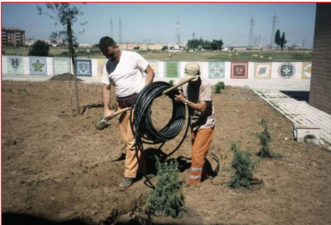
*Stesa nello scavo della tubazione di adduzione primaria (Ø 20 mm)*
