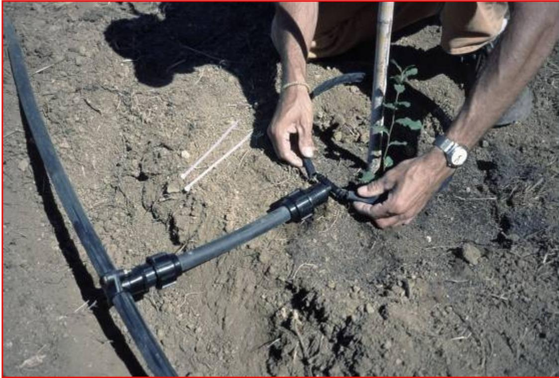
*Le due aperture della diramazione sono collegate con un anello di tubo essudante*
